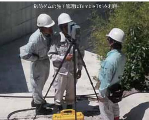
砂防ダムの施工管理にTrimble TX5を利用
